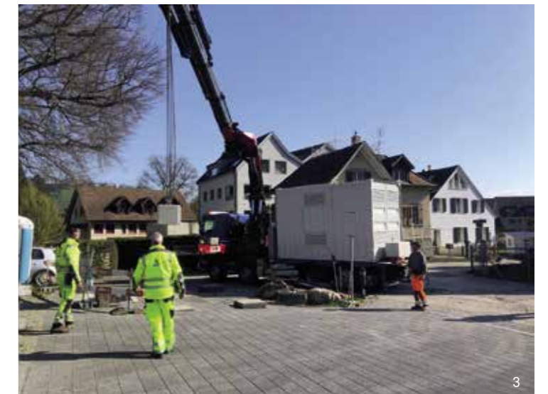
1. Werkleitungsbau Strigelgass 2. Werkleitungsbau Töberstrasse 3. Platzierung provisorische Trafostation Strigelgass
