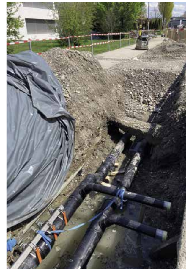
Anergienetz Altenrhein: Leitungsbau Dorfstrasse
