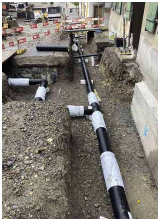
Leitungsbau Strigelgass (Kunststoffmantelverbundrohre DUO)
